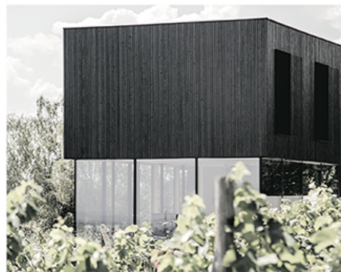
Wohnhaus mit verkohlter Holzfassade in den Weinbergen Niederösterreichs, geplant von Steinbauer architektur + design
